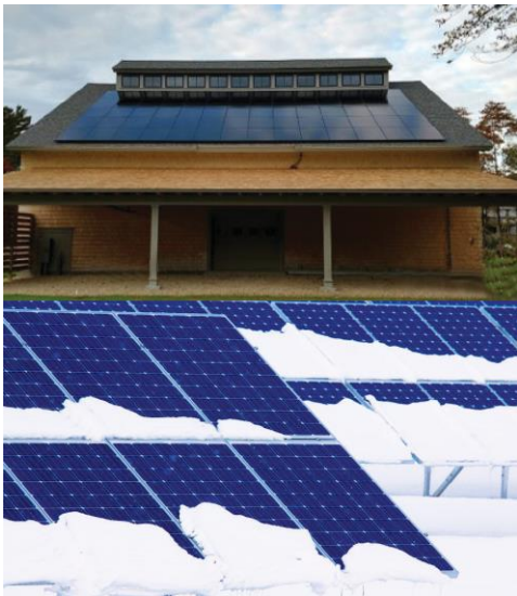
Fig.1: ombreggiamento dell'abbaino, foto per gentile concessione di Mass Renewables (in alto); ombreggiamento da parziale innevamento (sotto).
